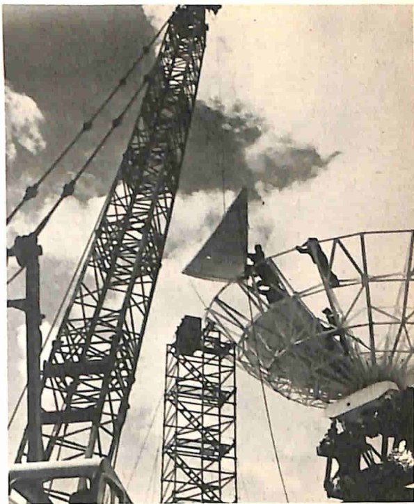
Alcuni tecnici sono intenti ad installare i pannelli dell'antenna destinata alla stazione terrestre per satelliti dell'isola di Ascensione.
