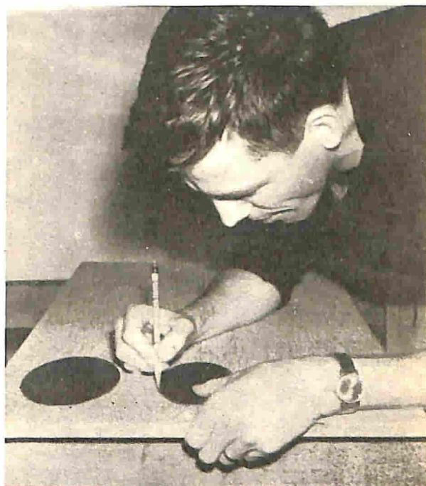
Fig. 4 - I modelli di cartone pesante permettono di disegnare agevolmente le aperture da praticare nel pannello frontale. A seconda delle dimensioni di ogni altoparlante utilizzato, è necessario fabbricarsi un modello appropriato.
