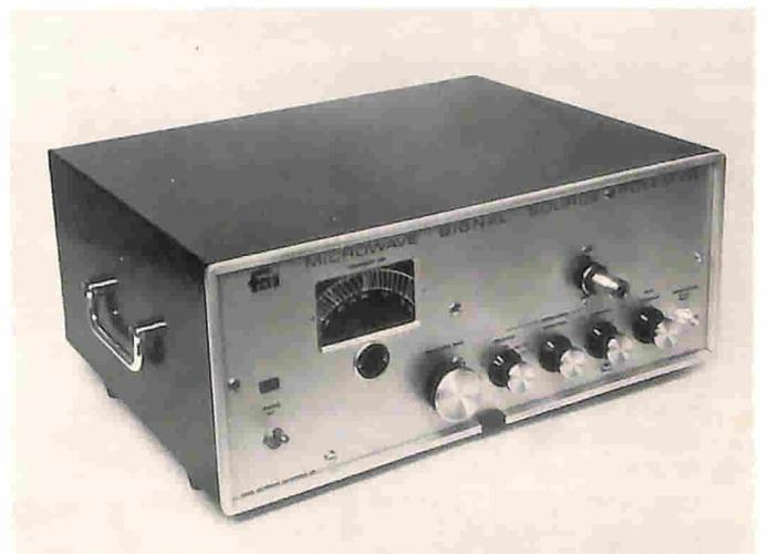
Generatore a klystron mod. PCLL costruito dalla FMI. Esso copre la gamma 0,8 ÷ 3,0 GHz con una potenza minima in uscita di 10mW.
