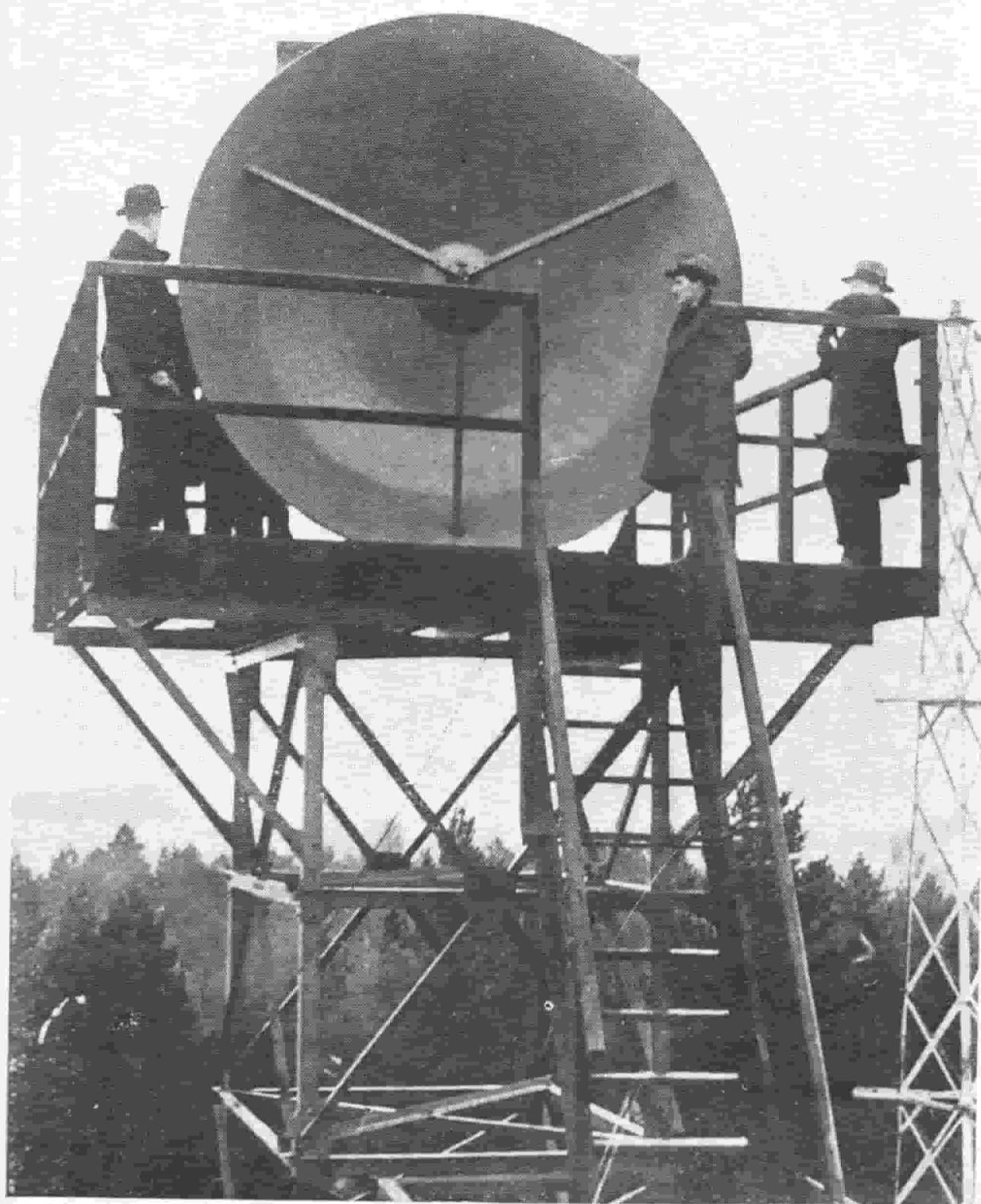
Gli aeroporti civili di Lymne, Inghilterra, e di St. Inglevert, Francia, sono stati collegati con un fascio di micro-onde, diretto come un raggio di luce mediante appositi proiettori. Nella fotografia è indicato il proiettore dell'aeroporto inglese.
